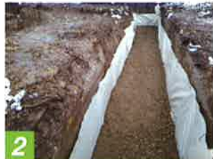
2 土木シートを敷き 砕石転圧します。
