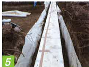
5 スーパージオ材の周りに 砕石敷きます。
