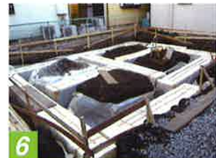
6 スーパージオ材の設置完了。
